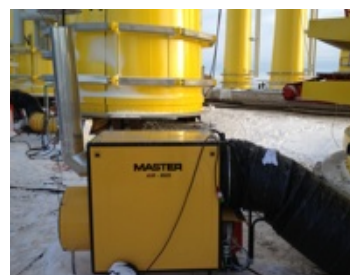
Строительные площадки со сложными условиями работы
